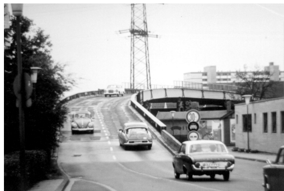
Die Stahlhochstraße in Leverkusen-Manfort (jeweils von Osten gesehen)
