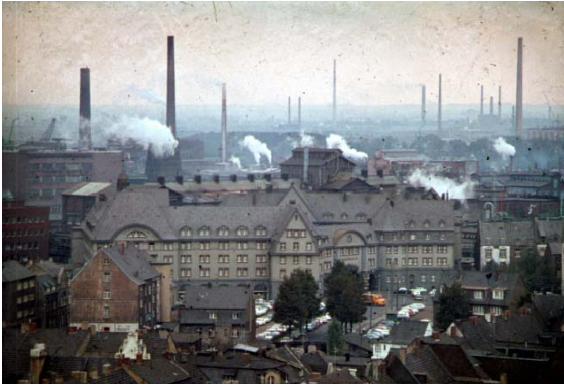
(4) Pfortner IV und Ledigenheim vor dem Abriss von Nordosten gesehen
