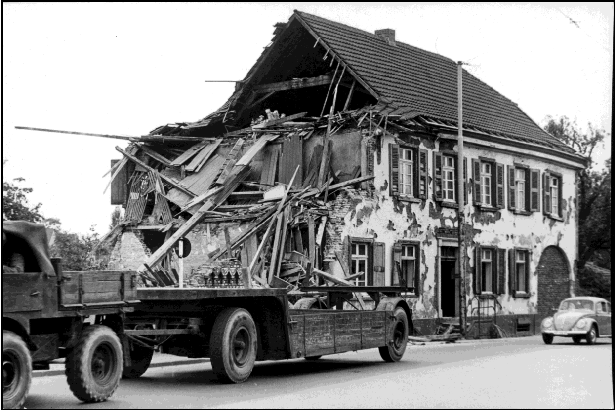
(4) Abbruch des Hofes Breidenbach (August 1963)
