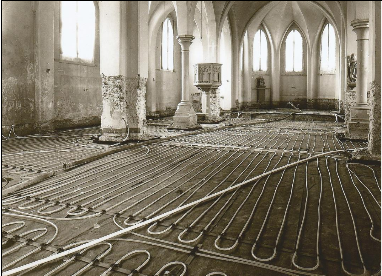
(1) Renovierung der Kirche in den 1970er-Jahren (u. a. Einbau einer Fußbodenheizung)
