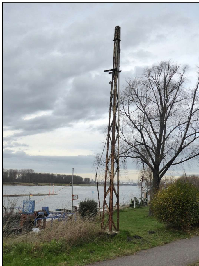
Bild 13: alter Oberleitungsmast Ecke Rheinstraße/Hitdorfer Straße (15.01.2020)
