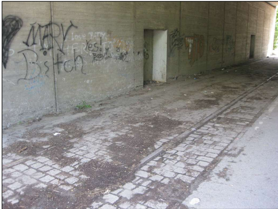
Bild 14: „totes“ Gleis in Rheindorf an der Autobahn-Unterführung (14.06.2013)
