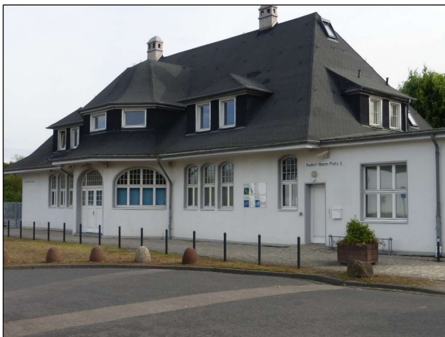
Bild 7: Der alte Bahnhof Wiesdorf (11.09.2016)
