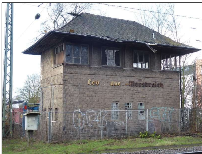
Bild 6: Das verfallene Betriebsgebäude des ehemaligen Bahnhofs Morsbroich (04.03.2020)
