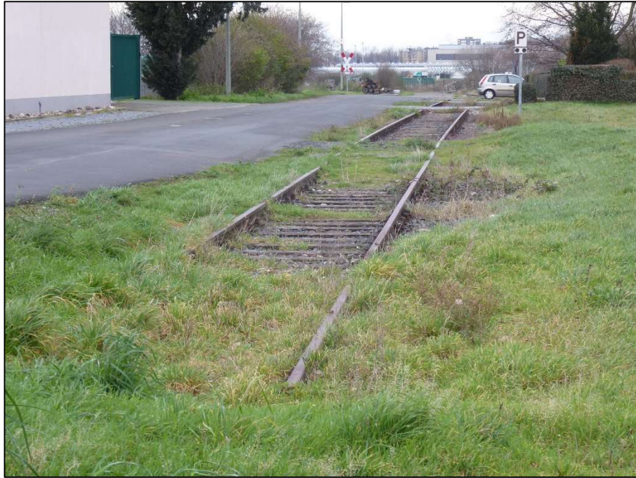
Bild 12: „totes“ Gleisende am Heerweg in Hitdorf (15.01.2020)
