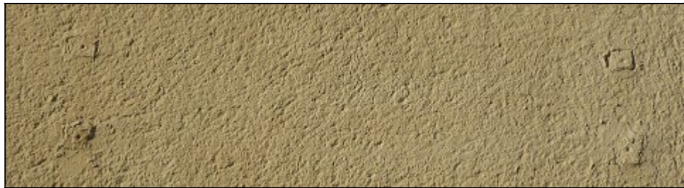
Spuren der ursprünglichen Befestigung eines Straßennamensschildes
